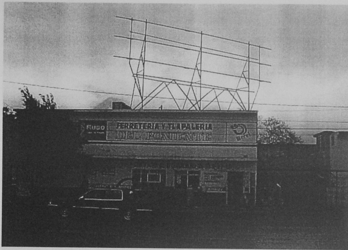
Retiro de estructura de la Ave. Vasconcelos
