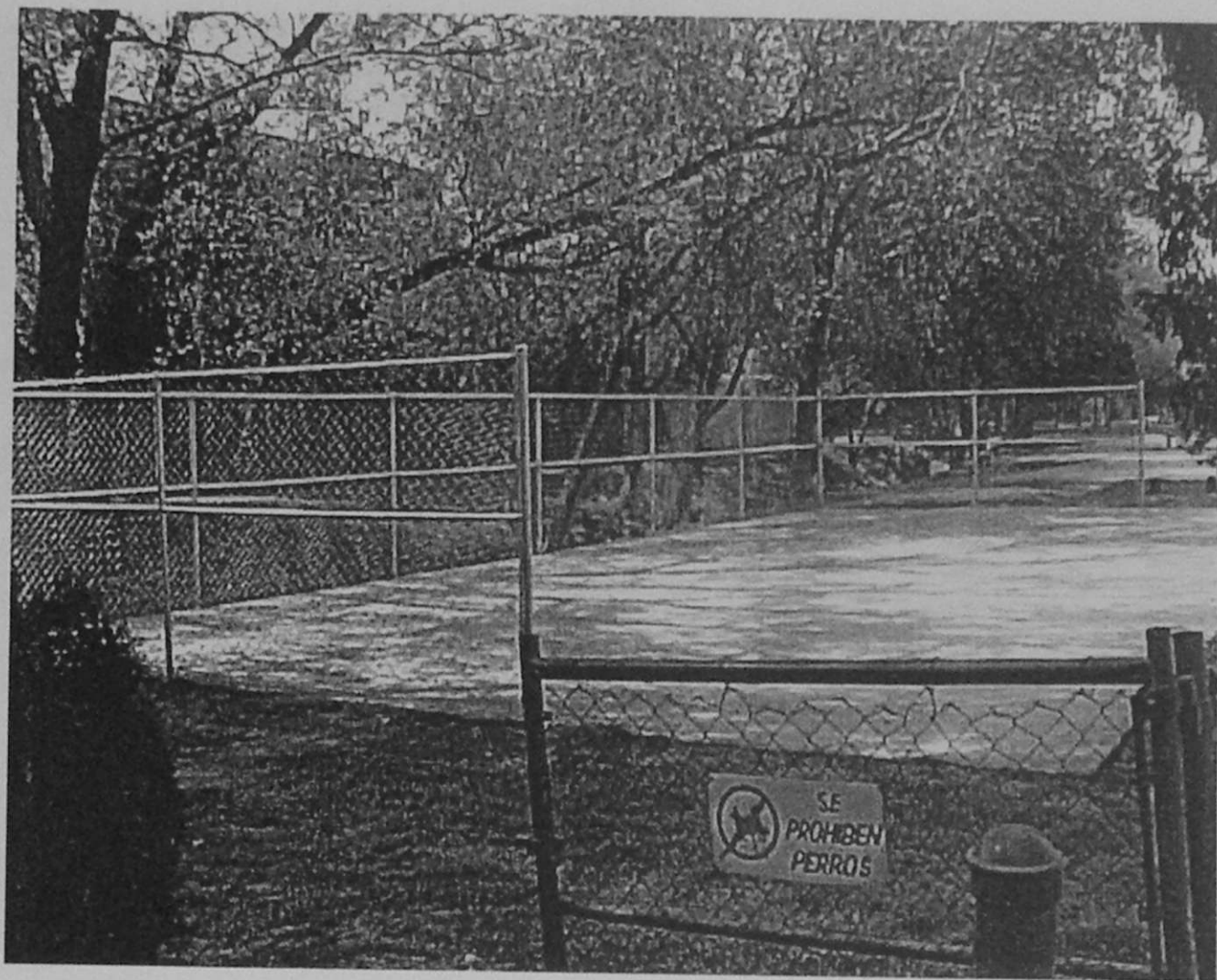
Instalación de malla ciclónica en Valle Oriente.
