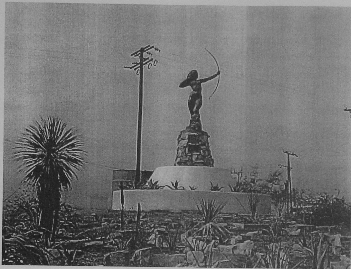
Mantenimiento al monumento de "La Diana" terminado.
